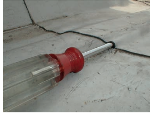
Bild 2. Offene Nahtstelle
